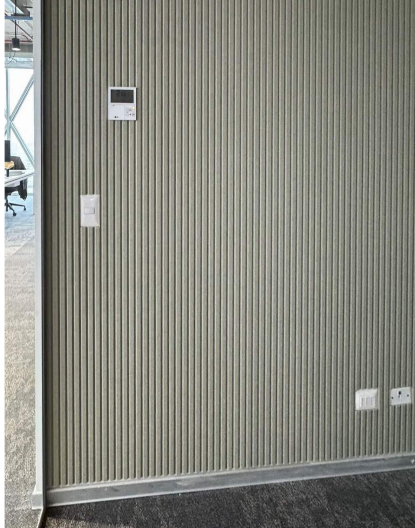
Intervención acústica en áreas de trabajo y espacios comunes, mediante la incorporación de baffles suspendidos, revestimientos murales y elementos divisores, articulados según la lógica funcional del proyecto.
